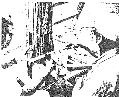
Foto 08 - Verificação com prumo de concreto
