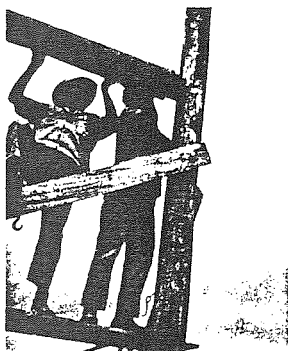
Foto 09 - Colocação da viga superior
