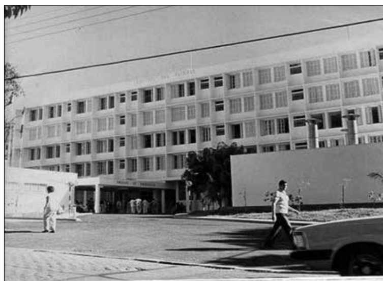
Figura 3 – Fachada da Unidade de Emergência do Hospital das Clínicas após construção da marquise e do Serviço de Nutrição (1987). Fonte: Santos (2002) 2 .
