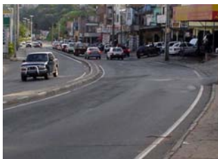
Figura 2: Foto da pista antes da aplicação do SMA com asfalto-borracha (ODA e EDEL, 2005).
