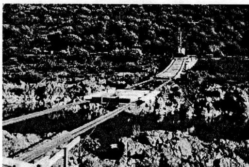
Figura 4 – Elemento pré-moldado deslizando até sua posição. (STRASKY (1999))
