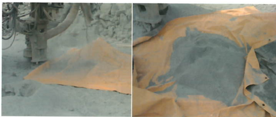
Figura 5 – Pilha cônica gerada pela perfuratriz.
