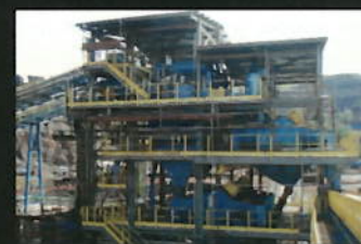
Planta de Beneficiamento de Minério de Ferro com Jigagem
