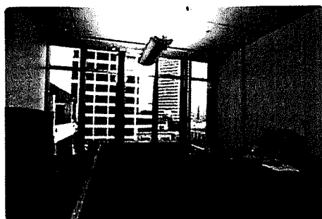
Vista do interior do apartamento testado durante um dia nublado. As janelas eletrocromicas estão no seu estado transparente sob condições de luz difusa (à esquerda). Com a entrada do sol, as janelas são automaticamente ativadas e ficam coloridas (à direita)
