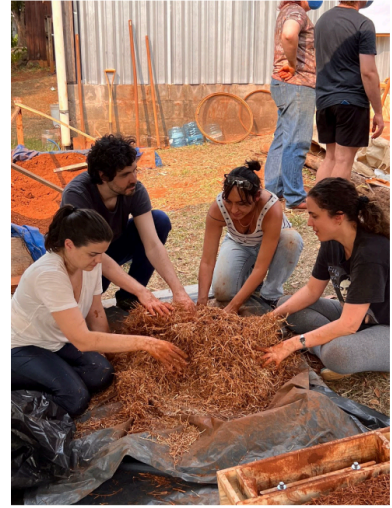
Figura 2: Mistura da palha com a barbotina Fonte: Acervo do grupo Habis
