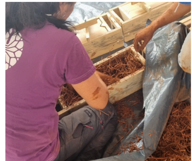
Figura 6: Montagem do bloco de adobillo Fonte: Acervo do grupo Habis
