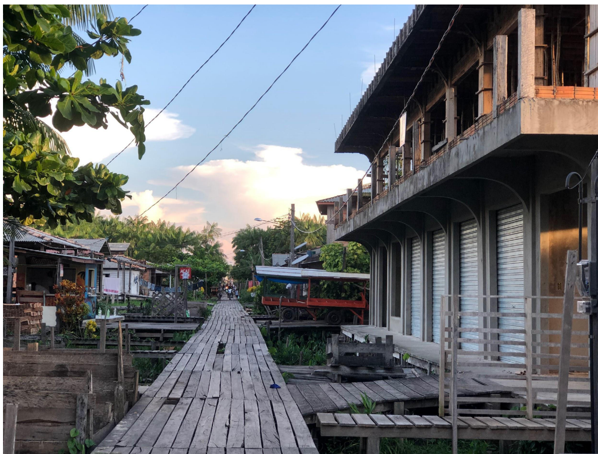
Figura 2: Conexões entre margens
