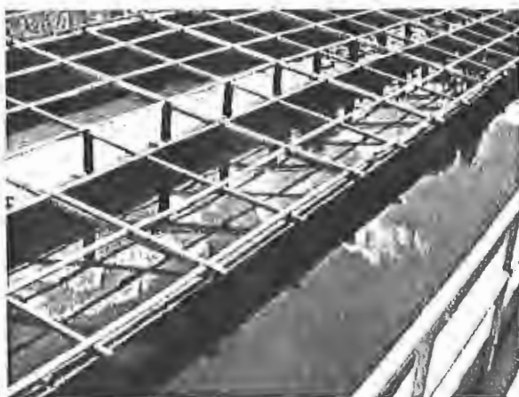
Figura 7.12 - Tanque de contato com regime de escoamento de fluxo pistão (ETE Caçadores - Cambé/PR)
