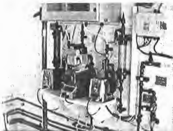
Figura 7.11 - Equipamentos de controle de dosagem de dióxido de cloro (ETE Caçadores - Cambé/PR)
