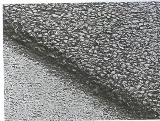
FIGURA 27.7 Stone matrix asphalt (SMA) em execução.
