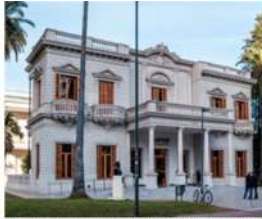
FICHA 242 - Palacio Canals - Nueva Sede IAPOS - Rosario
