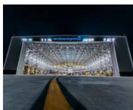
FICHA 201 - Hangar 5 Aerolíneas Argentinas - Ezeiza
