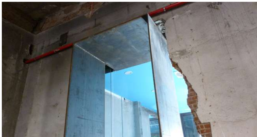
Figura 9. Detalla nave Espacio Intermediae. Fuente: Julio Arroyo.
