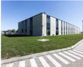
FICHA 132 - Edificio Administrativo Portuario - Berisso
