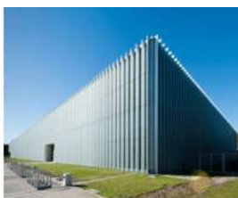
FICHA 240 - Edificio "Cero+Infinito" UBA - CABA
