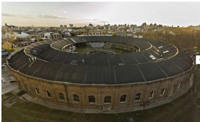
Figura 12. Ficha 01: Edificio Corona de Tornavías. Universidad Nacional de San Martín. Arquitecto Raúl Pieroni. La desafectación del servicio de gran cantidad de instalaciones ferroviarias durante el gobierno de Carlos Menem (1989–1999) dejó en condiciones de vacancia numerosas piezas patrimoniales de la llamada tradición funcional. Edificios de expresión robusta, de muros de ladrillos, con estructuras de cabriadas metálicas y cubiertas de chapas, son aptos para refuncionalizaciones que modifican el interior y preservan la imagen exterior del conjunto. Fuente: Summa+ 85.
