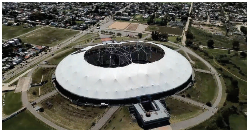
Figura 39. Ficha 60: Estadio Único de La Plata. Arq. Roberto Ferreira y Asociados. La innovación recae en la estructura tipo tensegrity con cubierta textil tensionada (que ha sufrido daños en distintas ocasiones). Uno de los pocos casos en que se observa una novedad constructiva.
