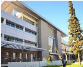
FICHA 279 - Obra Social Provincia - San Juan
