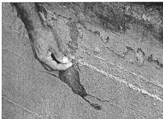
Figura 3 - Detalhe de campo da lateral de um bloco de fundação no qual se observa a exsudação de gel.
