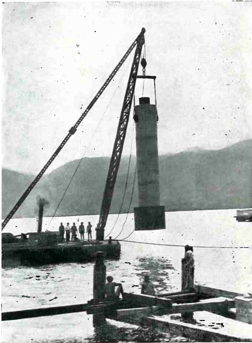
Fig. 64 — Transporte de um tubulão por meio de cabrea flutuante.
