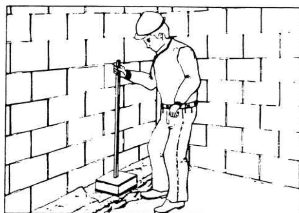
FIGURA 4.6: Início da execução das mestras: espalhamento da argamassa de contrapiso entre duas taliscas, após o preparo da camada de aderência e compactação enérgica da mestra, de modo a obter um contrapiso de elevada compacidade e no nível estabelecido.
