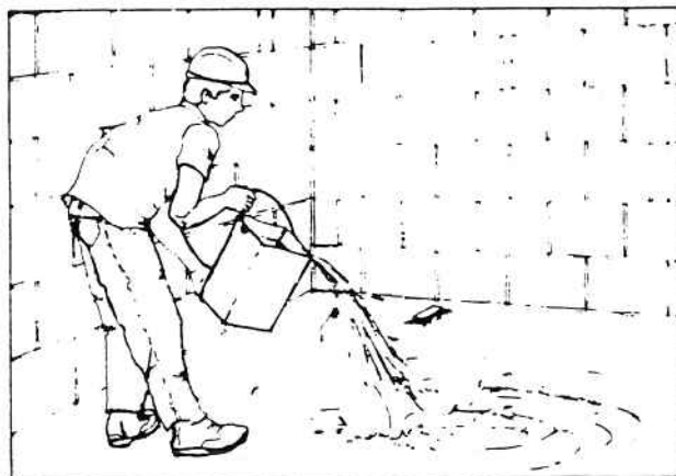
FIGURA 4.4: Remoção das partículas soltas e material pulverulento utilizando-se vassoura dura e lavagem com água em abundância.
