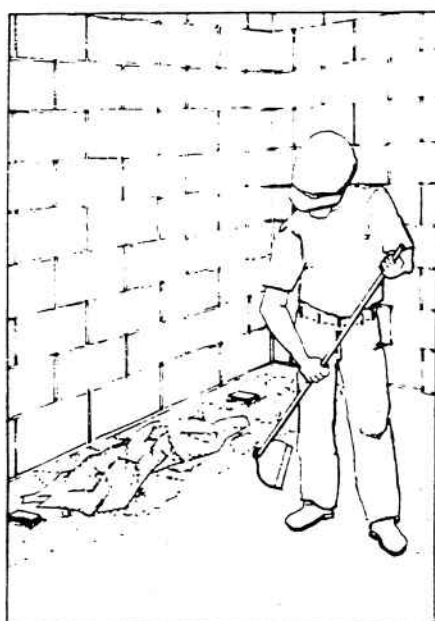
FIGURA 4.6: Início da execução das mestras: espalhamento da argamassa de contrapiso entre duas taliscas, após o preparo da camada de aderência e compactação enérgica da mestra, de modo a obter um contrapiso de elevada compacidade e no nível estabelecido.
