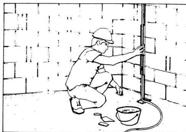
FIGURA 4.2 Assentamento da talisca empregando-se o aparelho de nível.
