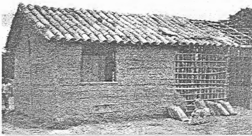
Foto 5:- Habitação de Taipa de Sopapo ou Taipa de Sapé. Local: Cidade de Garimpo -Chapada dos Guimarães-MT
