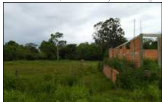
Figura 13 – Construção de residência na planície de inundação do Ribeirão Jataizinho
