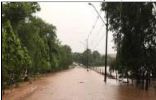
Figura 07 - Inundação da Avenida Orlando Salles Striquer (Pombal).
