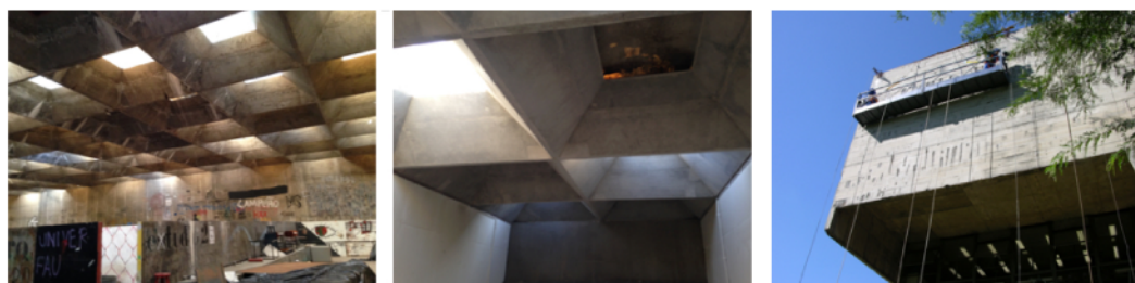
Figura 2. Carbonatação do concreto na cobertura; cobertura após recuperação e escarificação de concreto nas empenas
