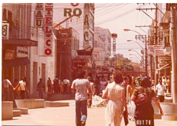
Figura 5. Início da construção do Calçadão, onde pode ser observada as características originais do projeto, 1979. Fonte: Museu e Arquivo Histórico de Presidente Prudente, 2018.
