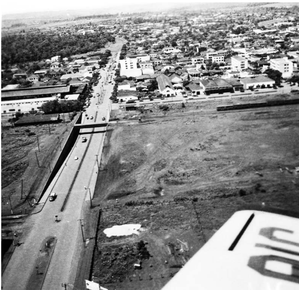
FIGURA 19 Foto mostrando o Viaduto do Café concluído.
