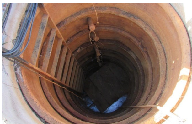
Figura 1. Estação de monitoramento instalada no interior do maciço de resíduos.
