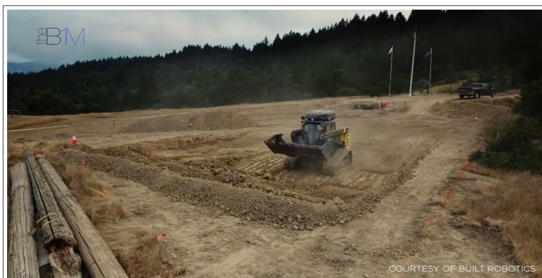
Figura 7.9: Serviço automatizado de terraplenagem.
