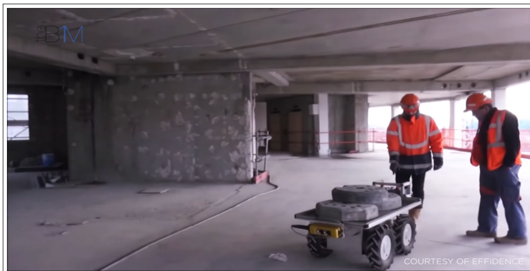
Figura 7.8: Transporte de material pesado em obra por robô.
