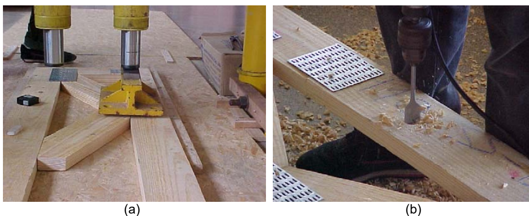
Figura 8 - (a) Prensagem (b) Furação para posterior passagem das barras de protensão.
