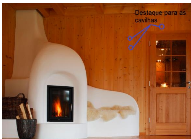
Figura 3- Exemplo de estrutura construída em painel de lamelas cruzadas cavilhada
