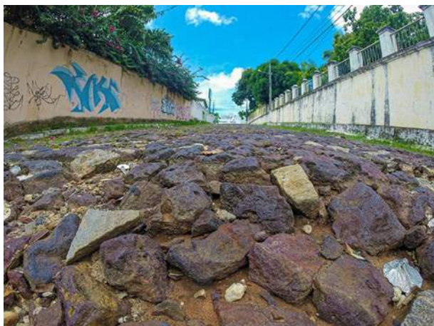
FIGURA 8.7: Travessa Pax, exemplo de calçamento completo na cidade do Natal com uso de arenitos ferruginosos.
