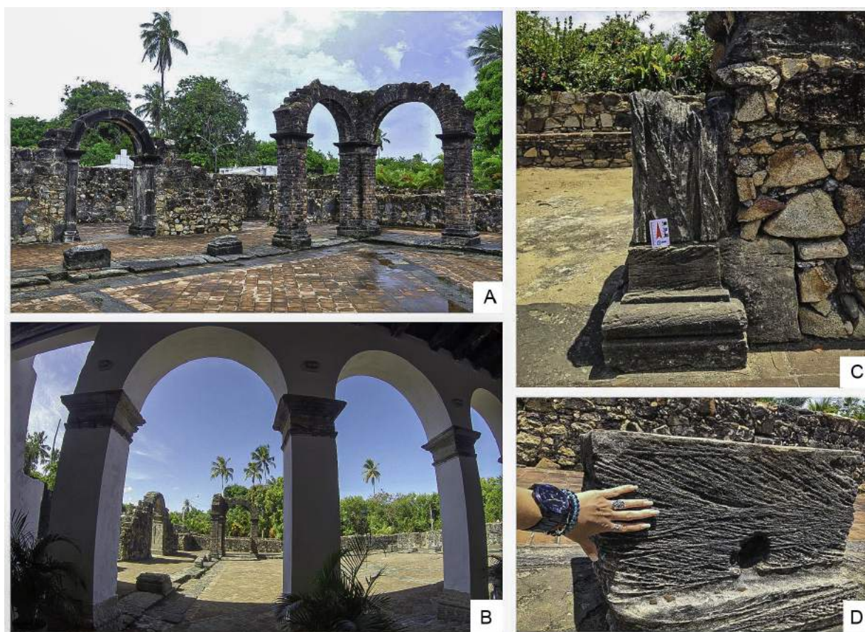
FIGURA 10.10: Ruínas do Convento Carmelita. A e B. Detalhe para as paredes e pilares em blocos graníticos e arcos e detalhes em arenitos de praia, trabalhadas em cantarias. C e D. detalhe das estratificações preservadas nos arenitos de praia ( beachrocks ).
