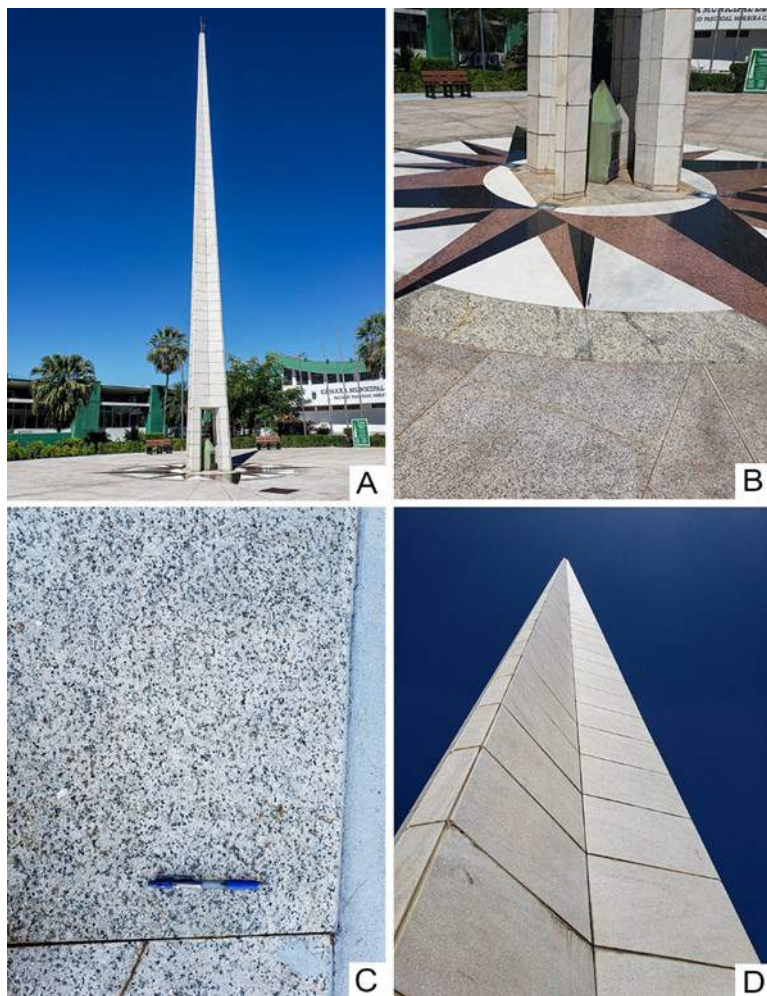
FIGURA 12.2: Ponto 1 - Marco do Centro Geodésico da América do Sul. A. Obelisco. B. Base da estrutura: em preto – gabro, em vermelho – sienogranito, em branco – mármore. C. Praça e entorno - granito cinza claro. D. Estrutura principal – mármore maciço branco.
