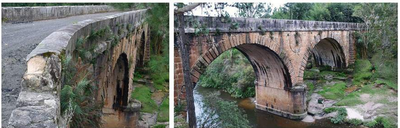
FIGURA 19.8: Detalhes da Ponte do Imperador, em Porto Amazonas. Apesar de seu trânsito ter sido desviado e seu tombamento como patrimônio histórico em 1973, a ponte recebeu asfalto e está sujeita ainda à passagem de veículos e à degradação por ação humana.
