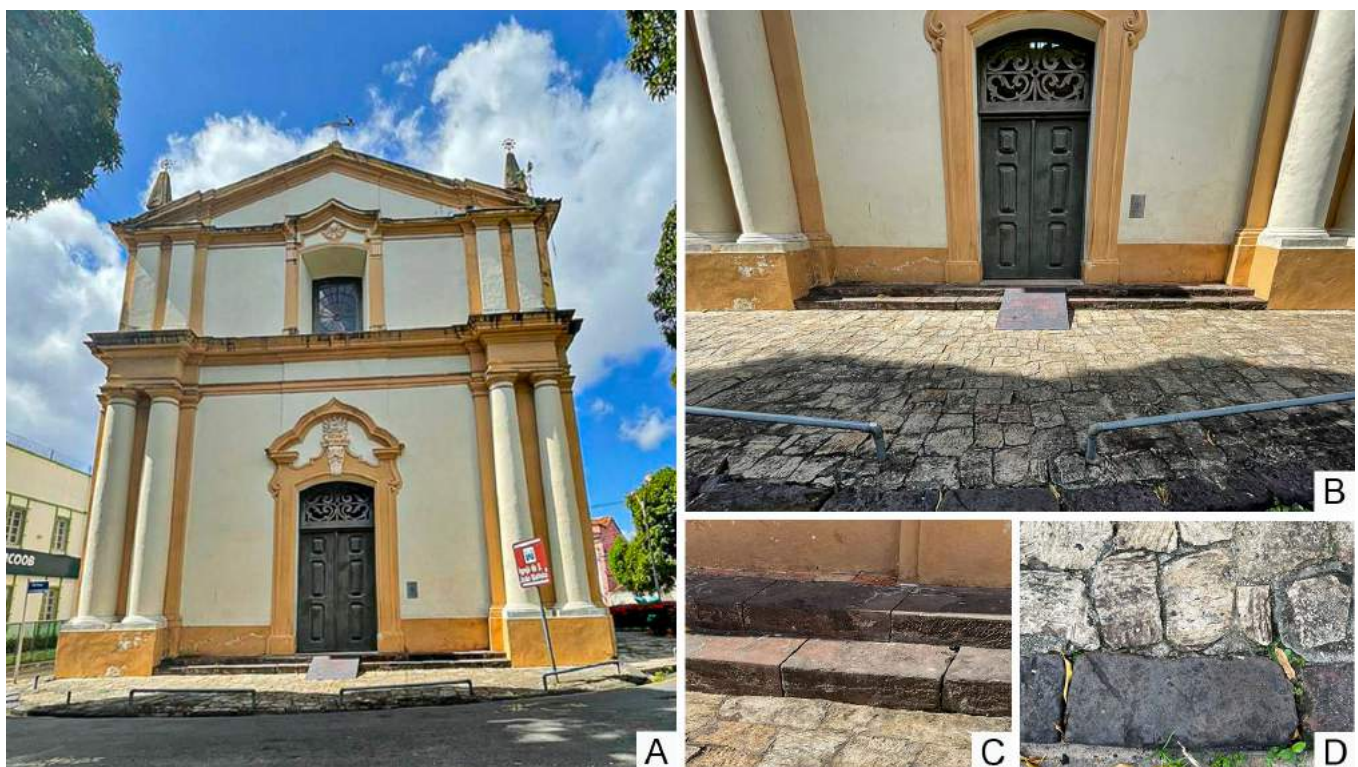
FIGURA 5.3: Igreja de São João Batista no bairro da Campina. A. Fachada frontal. B. Detalhe geral do calçamento a frente da igreja com o arenito ferruginoso (pedra que a região oferecia/oferece) aplicado na escadaria e no meio-fio e granito com face polida, de corte irregular no restante do calçamento. C. Detalhe da escadaria com blocos de arenito ferruginoso, com cantaria bem executada, aparelhado em todas as faces e de tamanhos aproximados. D. Detalhe do meio-fio em bloco de arenito ferruginoso, com acabamento mais irregular.
