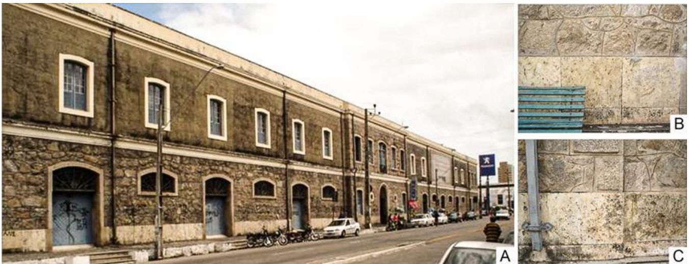
FIGURA 7.16: A. Prédio da antiga Alfândega, apelidado “Gigante de Pedra”. B. Detalhe interno do alicerce (em calcário) e da fachada (em granito). C. Detalhe externo do alicerce (em calcário) e da fachada (em granito) com deterioração diferenciada entre as duas rochas.
