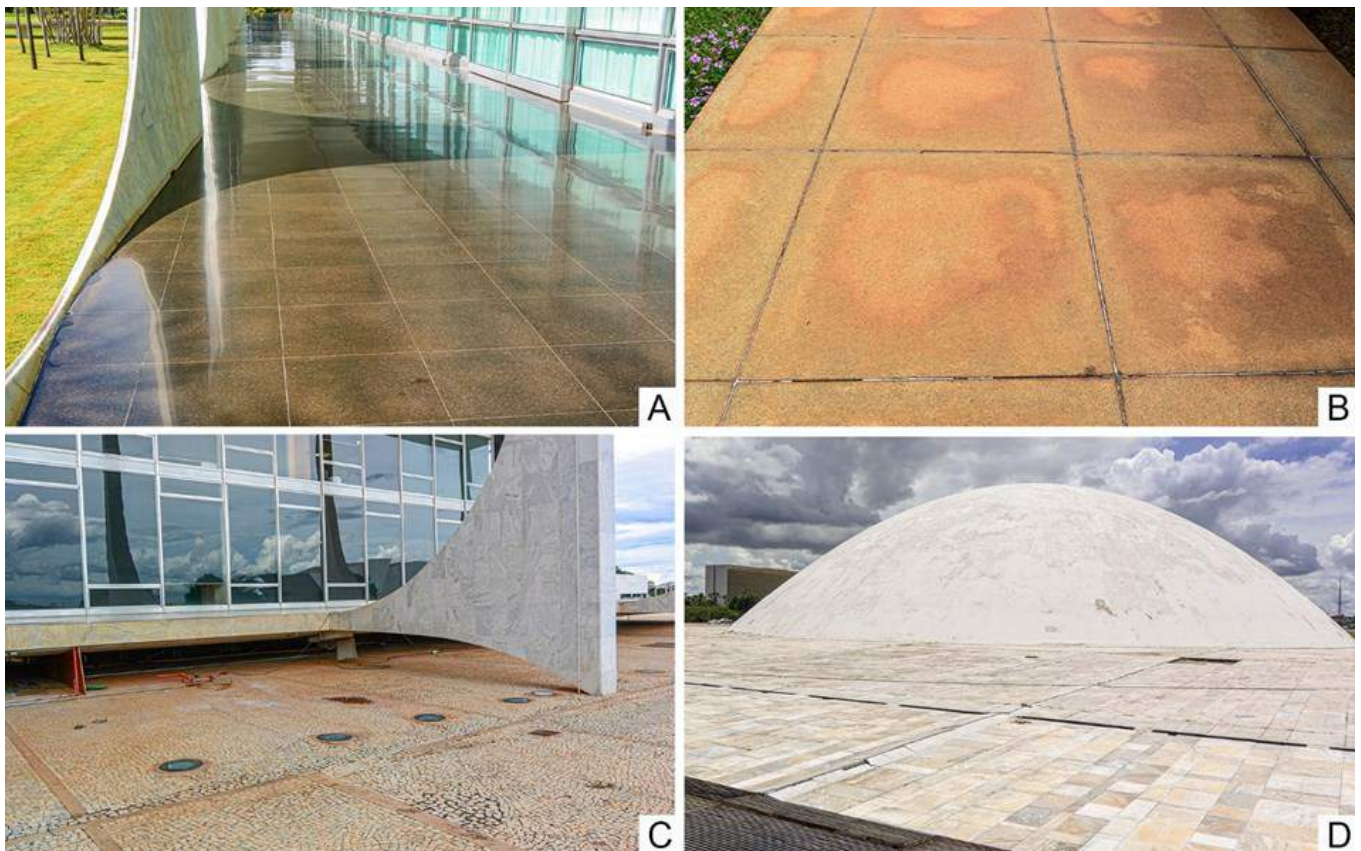
FIGURA 13.18: Aspectos da coloração avermelhada das pedras em revestimentos diversos de Brasília. A. Preto Tijuca na varanda do Alvorada, com tonalidade avermelhada pela ação da sujeira e possível uso de produtos de limpeza inadequados. B. Cinza Andorinha com intensa coloração avermelhada pela ação do solo local. C. Intensa sujeira avermelhada na pedra portuguesa nas proximidades do STF. D. Mármore com coloração avermelhada na plataforma do Congresso Nacional.
