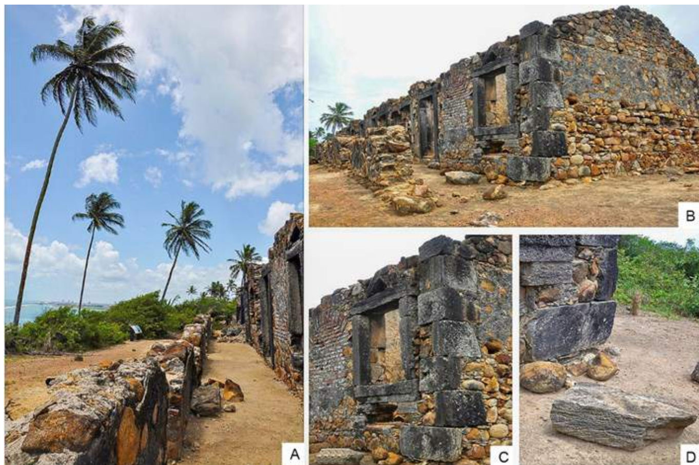
FIGURA 10.15: Quartel Velho. A e B. Lateral do quartel, sentido N-S. C e D. Detalhe dos blocos de granito e arenitos de praia, materiais péticos utilizados na construção original.
