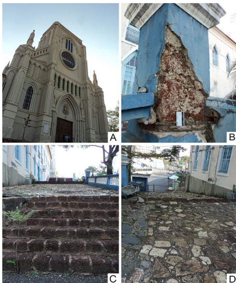
FIGURA 12.12: Ponto 11 - Igreja Nossa Senhora do Bom Despacho. A. Fachada com torre central e janelas com vitrais em estilo neogótico. B. Coluna do antigo muro de acesso, onde se observa blocos de pedra-canga revestidos parcialmente com argamassa. C. Escada lateral ao Seminário, com degraus em pedra-canga. D. Antiga rampa de acesso ao lado do Seminário, com blocos de pedra-canga, quartzo e calcário, de formas e tamanho variados.
