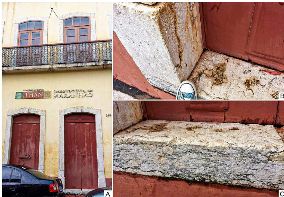
FIGURA 6.9: A. Pórtico e soleira na entrada do prédio do Iphan/MA formado por Calcário Lioz. B. Detalhes dos blocos construídos em calcário com inúmeros fósseis. C. Calcário Lioz com marcas de dissolução parcial (planos estilolíticos - superfícies marcadas e evidenciadas por um plano que separa duas massas rochosas, com a aparência de uma fina sutura, de tonalidade escura, provavelmente resultado da acumulação de argilominerais) e pedaços de conchas de rudistas (radiolítídeos?).
