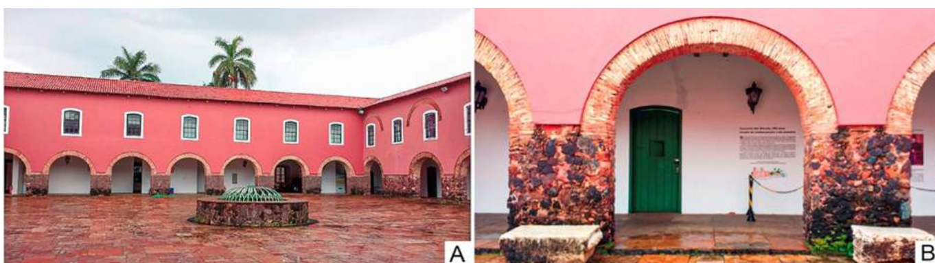
FIGURA 6.11: A. Colunas em arcos em adobe com arenitos ferruginosos na base. B. Detalhe dos arenitos ferruginosos de cor escura nas bases das colunas.
