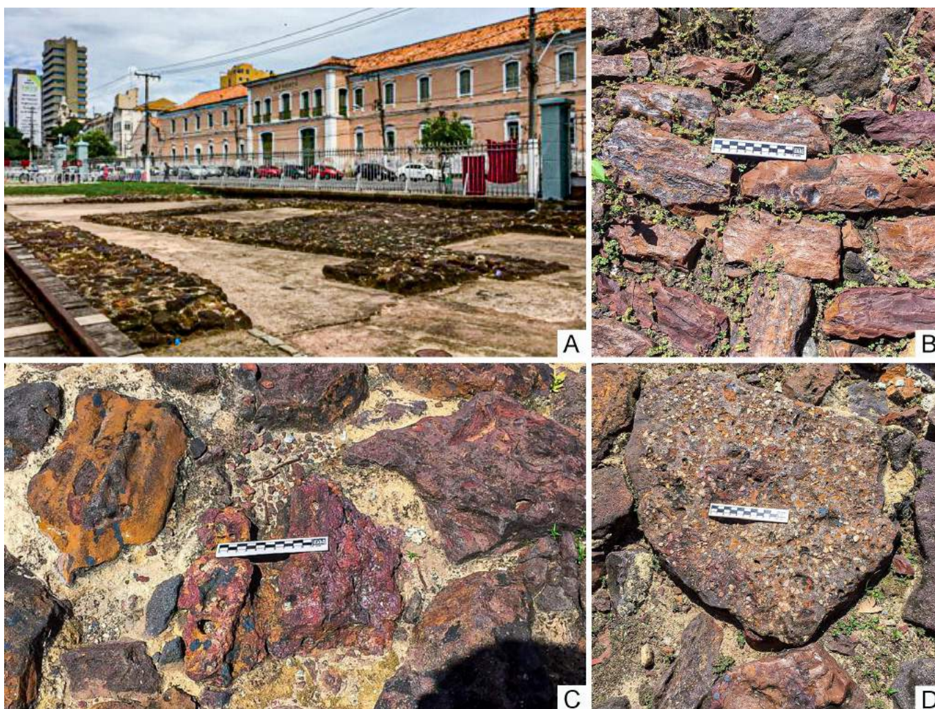
FIGURA 3.8: A. Ruínas do Forte São Pedro Nolasco em Belém do Pará, consolidadas no Complexo Estação das Docas. B. Base de edificação da praça com fragmentos de pedras de ferro. C. Blocos de crostas lateríticas. D. Arenitos ferruginizados e conglomeráticos.
