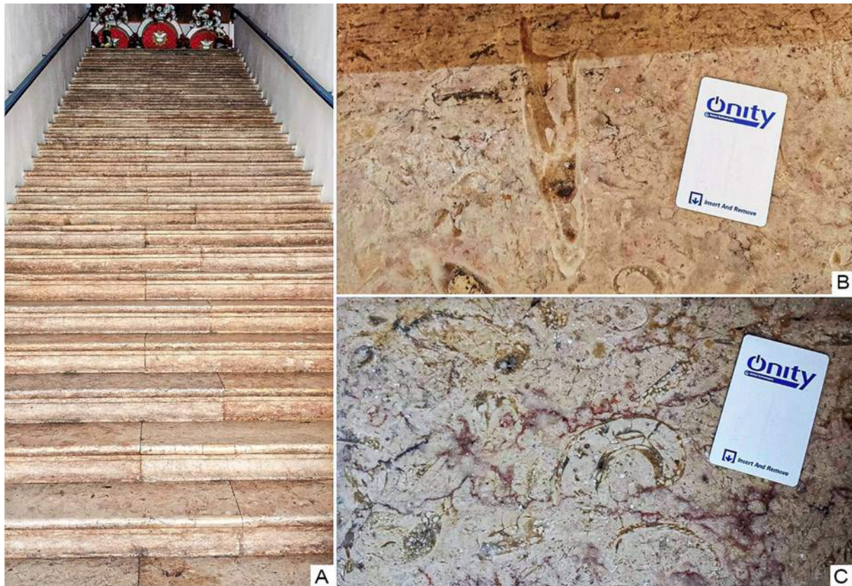
FIGURA 6.5: Exemplos do Calcário Lioz na Casa do Maranhão. A. Escadaria que dá acesso a exposição cultural. B. Corte longitudinal de um radiolítico. C. Corte transversal de um caprinídeo, ambos em calcários da escadaria.
