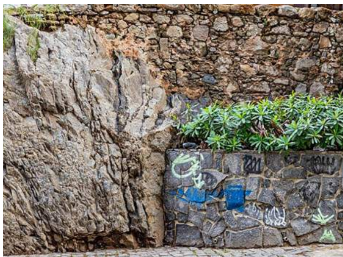
FIGURA 15.12: Esfoliação esferoidal do Granito Rio Aribiri utilizado como substrato da construção. Fotografia: Paul R. Burley.
