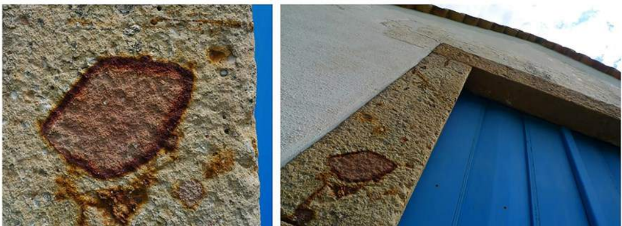
FIGURA 19.7: Detalhes da Capela do Tamanduá, em São Luiz do Purunã. Portadas de janelas e portas entalhadas em diamictitos do Grupo Itararé.
