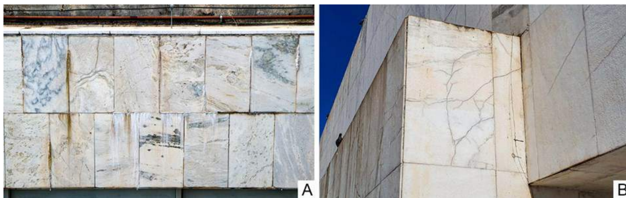
FIGURA 13.19: Outras deteriorações observadas nos monumentos de Brasília. A. Trecho com incrustações na platibanda do Congresso Nacional. B. Fraturas e sujidades em revestimento do Museu da Cidade.
