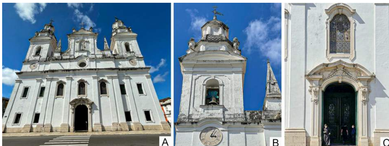
FIGURA 5.4: Imagens da Catedral da Sé de Belém. A. Fachada principal na qual observa-se o uso do Lioz no embasamento, na base do relógio de ambas as torres, na portada principal e nos três vãos centrais. B. Detalhe da base do relógio em Lioz. C. Detalhe da portada com o vão emoldurado, ambos em Lioz.
