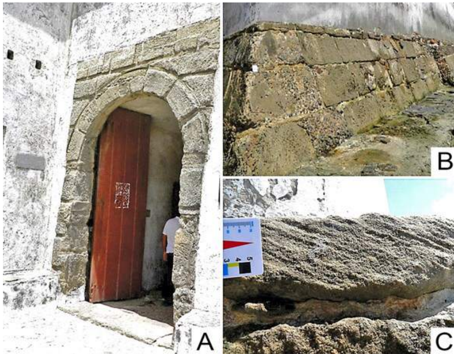
FIGURA 8.5: Arenitos calcíferos foram usados no Forte dos Reis Magos como portais (A) e fundação (B), essencialmente. Em alguns blocos é possível distinguir estratificações (C).
