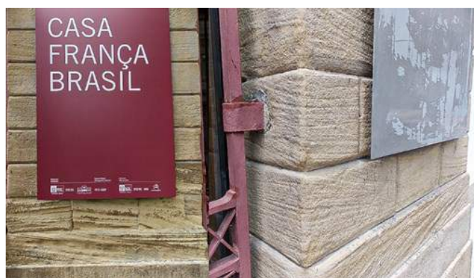
FIGURA 20.2: Estratificação sedimentar do Arenito Itararé na fachada da Casa França-Brasil, na cidade do Rio de Janeiro. A origem deste arenito é atribuída ao Grupo Itararé, da Bacia do Paraná.
