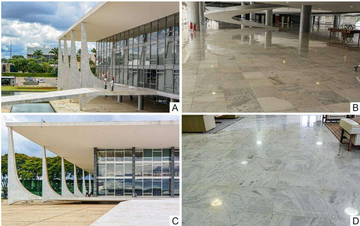
FIGURA 13.11: Mármore branco no revestimento exterior e interior do Planalto e STF. A. Fachada do Palácio do Planalto. B. Piso interno do Palácio do Planalto. C. Fachada do Supremo Tribunal Federal. D. Piso interno do Supremo Tribunal Federal.
