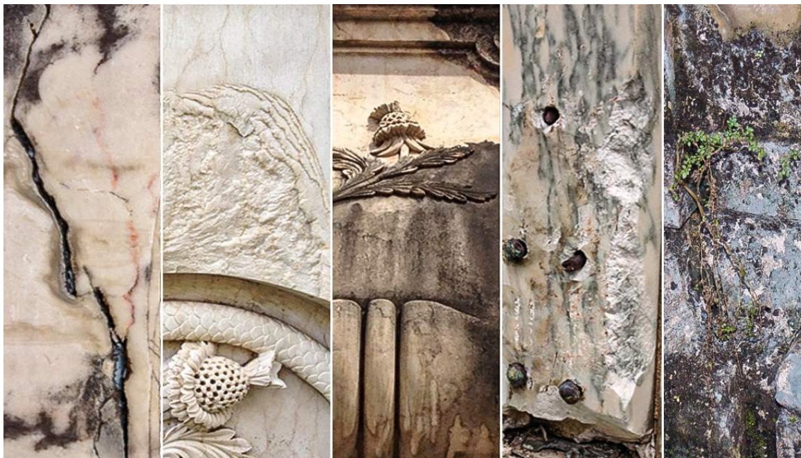
Figura 5.10: Tipos de alterações encontrados em pedras dos monumentos funerários do Cemitério da Soledade, pertencentes a cada um dos grupos de padrões do Glossário do Icomos.
