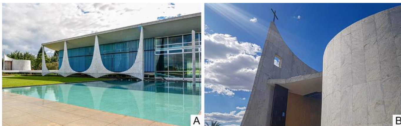
FIGURA 13.8: Mármore branco no revestimento do Palácio do Alvorada. A. Fachada do Palácio do Alvorada e capela, ao fundo. B. Detalhe do revestimento em mármore branco (provável Branco Italva) da Capela do Palácio do Alvorada.
