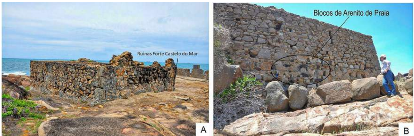
FIGURA 10.14: Forte Castelo do Mar. A. Vista geral do forte - Sul-Norte. B. Parede lateral, edificada essencialmente com blocos graníticos e alguns blocos areníticos.
