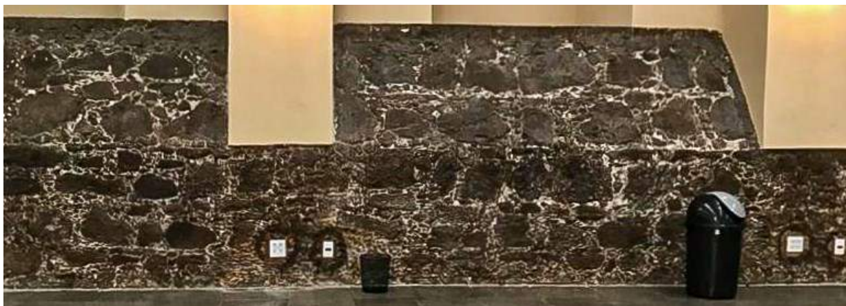
FIGURA 5.1: Fundação em pedra com blocos irregulares de arenito ferruginoso, de diferentes dimensões, com espaço entre eles preenchido com pedras menores, do antigo Convento dos Mercedários.
