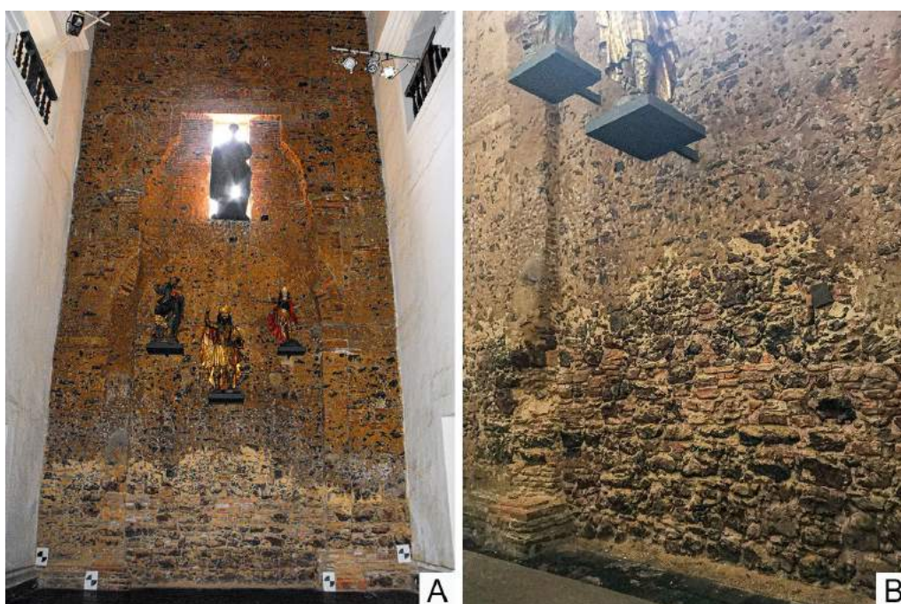
FIGURA 5.2: A alvenaria de pedra da Igreja de Santo Alexandre. A. Parede do transepto com a alvenaria mista de pedra e tijolo aparente, na qual observa-se a utilização de blocos irregulares de diferentes dimensões, e mancha inferior de umidade ascendente. B. Ausência de tratamento na superfície da pedra e arenização da pedra e do tijolo provocada por cristalização de sais. Fotografia A: Mário Mendonça de Oliveira.
