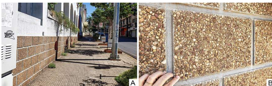
FIGURA 12.6: Ponto 5 - Prédio histórico situado na Rua Joaquim Murtinho. A. Fachada lateral na Av. Getúlio Vargas. B. Detalhe dos seixos, de material misto, provável resíduo de mineração.
