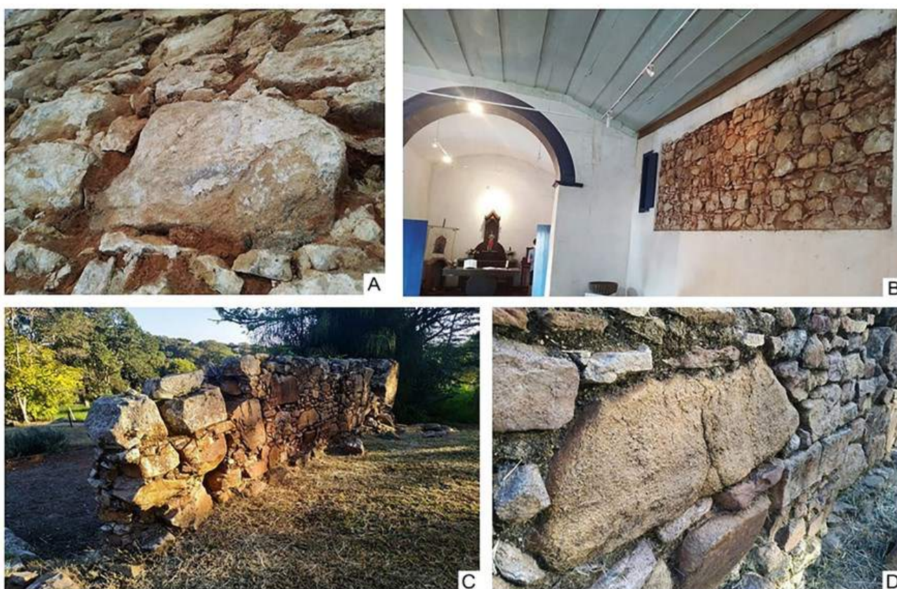
FIGURA 19.5: Capela Santa Bárbara, em Ponta Grossa. A e B. No projeto de restauração de 2002, a estrutura das paredes ficou à mostra, evidenciando os blocos de arenito (Formação Furnas?). C e D. Remanescentes de muros que cercavam originalmente a capela também foram construídos com a mesma rocha.
