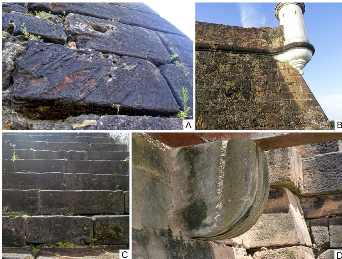
FIGURA 3.7: Arenitos ferruginizados em estruturas da Fortaleza de São José de Macapá (AP). A. Bloco em cantaria em cunhal de baluarte com estratificação cruzada. B. Blocos em cantaria nos cunhais, de formato irregular nas muralhas e em cortes curvos no cordão e base da guarita (pintada). C. Escadaria de acesso ao terrapleno. D. Console da ponte levadiça.
