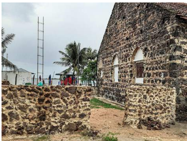
FIGURA 8.10: Obra de ampliação recente da igreja, onde foram utilizados os mesmos materiais, blocos de arenitos ferruginosos, e técnicas de construção.
