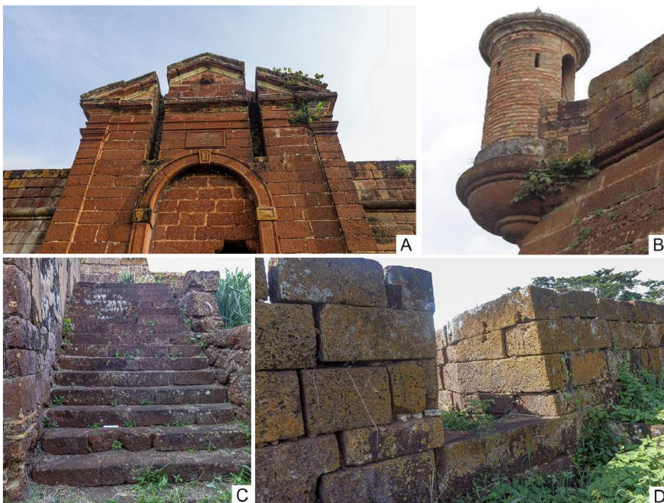
FIGURA 3.10: Blocos de crostas lateríticas no Forte Príncipe da Beira (RO). A. Blocos em cantaria regular e em formas curvas na portada e na muralha em diversos elementos: cordão, parapeito, placa com inscrição em baixo relevo, frisos, moldura, arco, chave e coroa entalhada no frontão segmentado. B. Base da guarita, parapeito e cordão do baluarte Santo André Avelino. C. Escadaria de acesso ao terraço. D. Parapeito e canhoneira visto pelo terraço.
