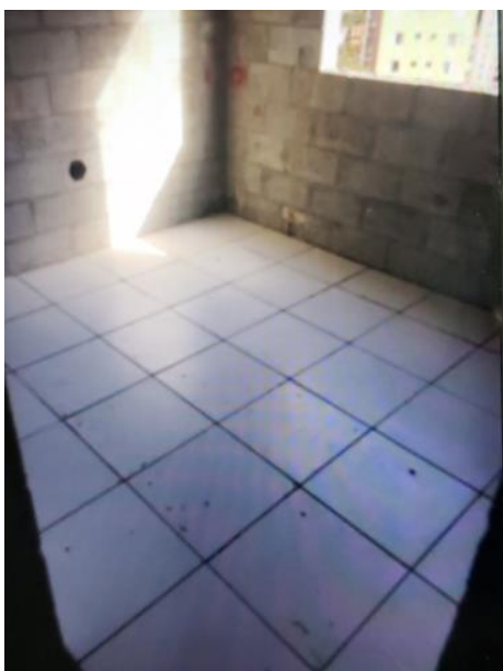
Figura 8 – Cerâmica com cortiça aplicada no ambiente a ser ensaiado
