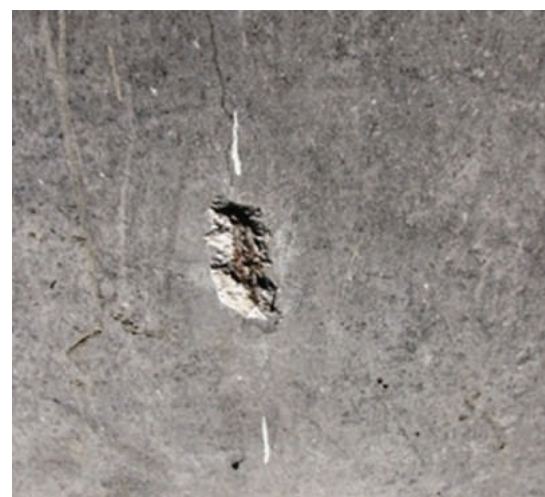
FOTO 2 – AUMENTO DA POROSIDADE DO CONCRETO EXPOSTO Fonte: ARQUIVO PESSOAL DO AUTOR (TOMAZELI, 2012, p. 83)
