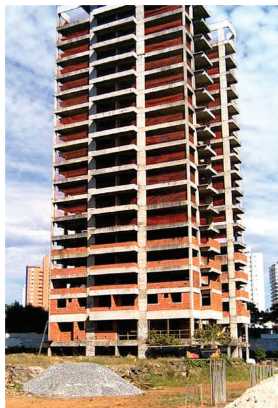
FOTO 1 – VISTA DE OBRA PARALISADA COM ESTRUTURA À VISTA.
