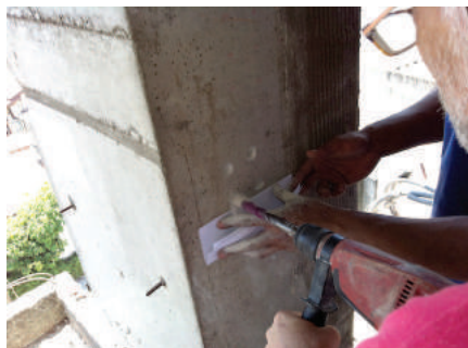
FOTO 7 – FUROS COM BROCA E FURADEIRA NO PILAR PARA COLETA DAS AMOSTRAS
