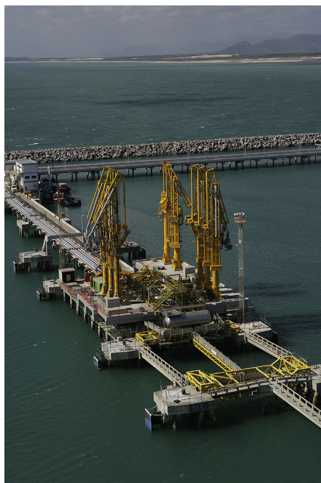
Fig. 5. Brazilian LNG Terminal with transfer arms Petrobras (2015).
