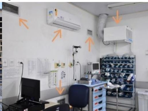
Figura 20: Condicionamento híbrido.
