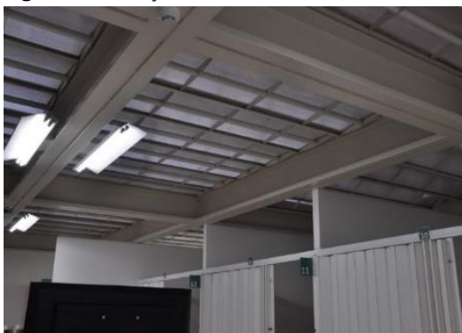
Figura 21: Vedação dos forros basculantes.
