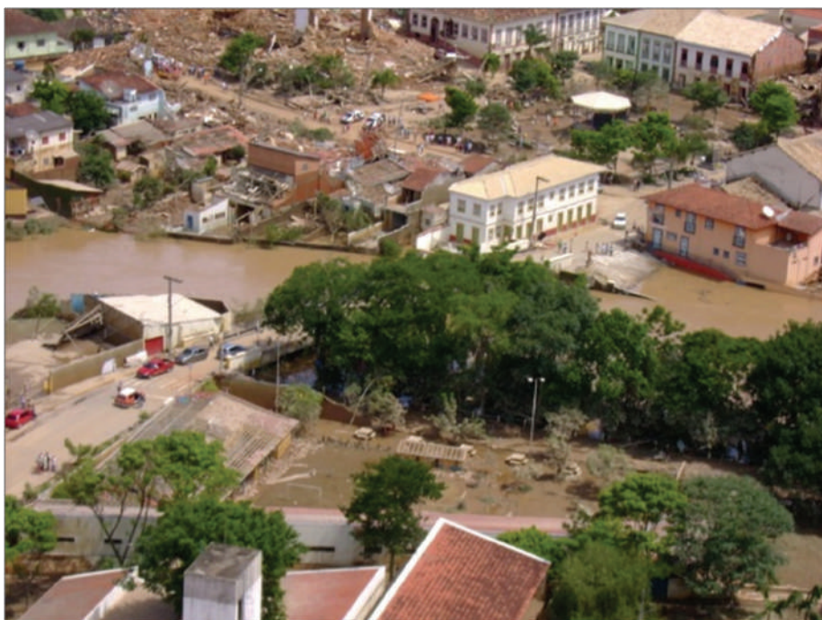
Figura 15 São Luiz do Paraitinga após inundações de dezembro de 2009. Fonte: IPT.
