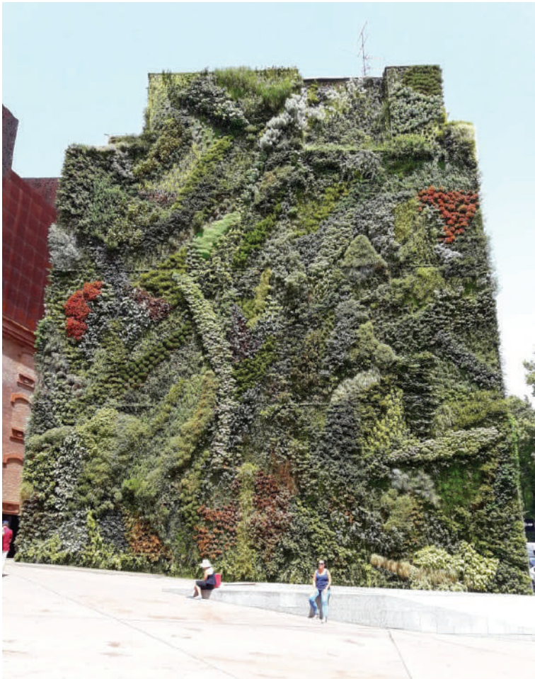
Figura 6 Sistema de muro vivo contínuo, Caixa Forum, Madrid, Construído em junho de 2013 por Patrick Blanc. Fonte: Gallardo (2017) 43 .
