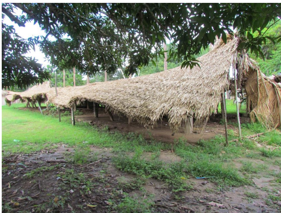
Figura 11. tavyva Kwatinema em colapso (2018).
