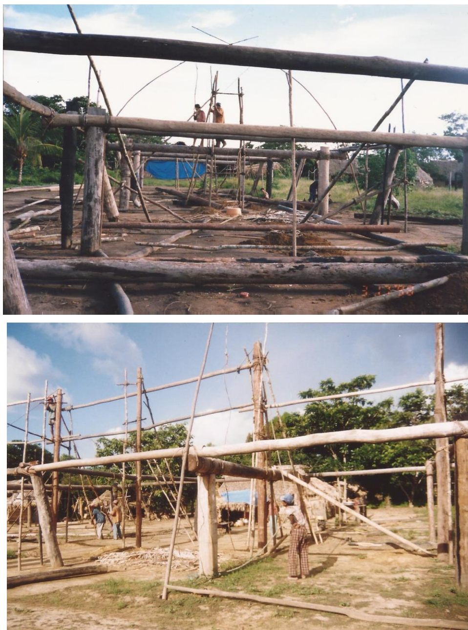
Figura 6. a) construção da estrutura da tavyva (frechais laterais, travessões esteios); b) finalização da construção da estrutura da tavyva (frechais laterais, esteios, travessões, longarina e cumeeira).
