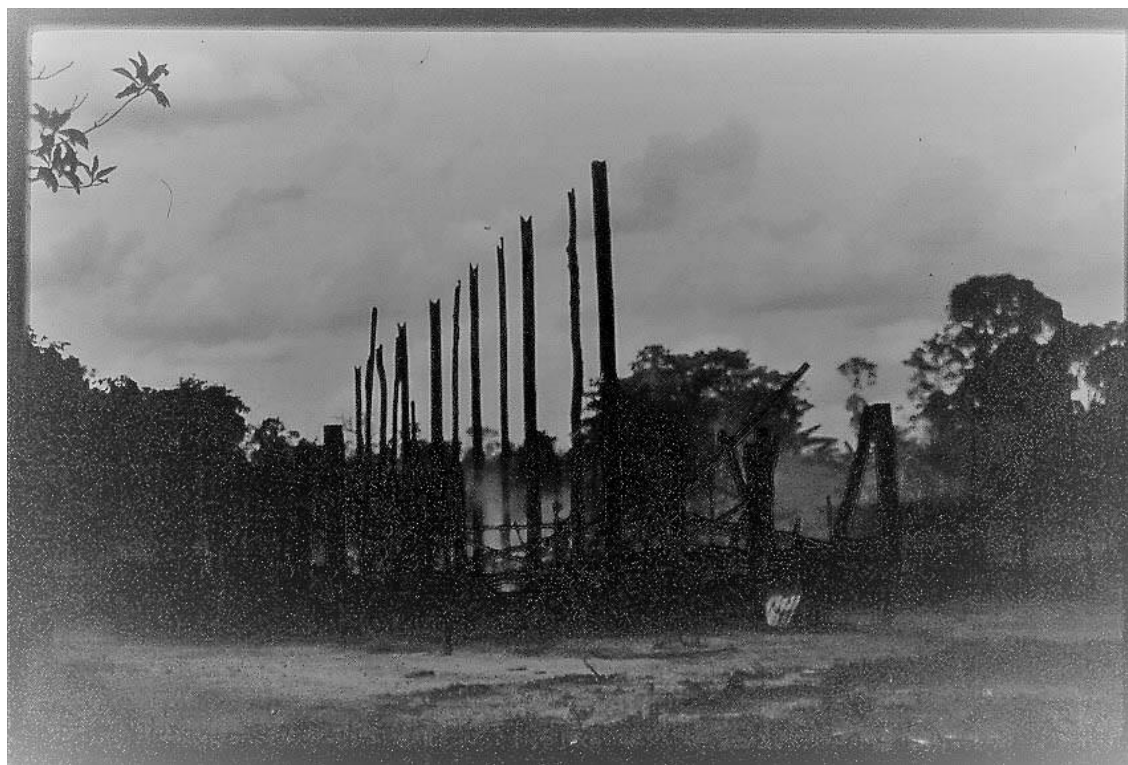
Figura 2. Tavyva Kwatinema destruída pelo fogo (1996).
