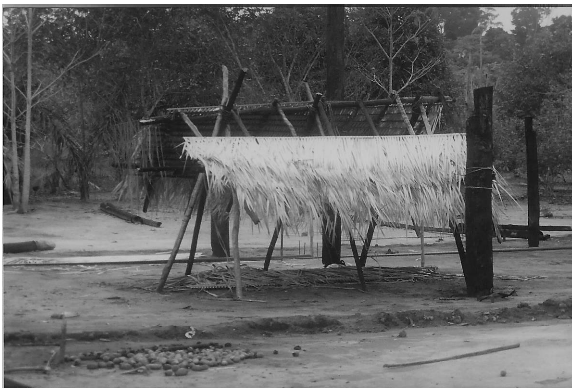
Figura 4. Detalhe da área de sepultamento na área interna da tavyva após a limpeza dos vestígios do incêndio.
