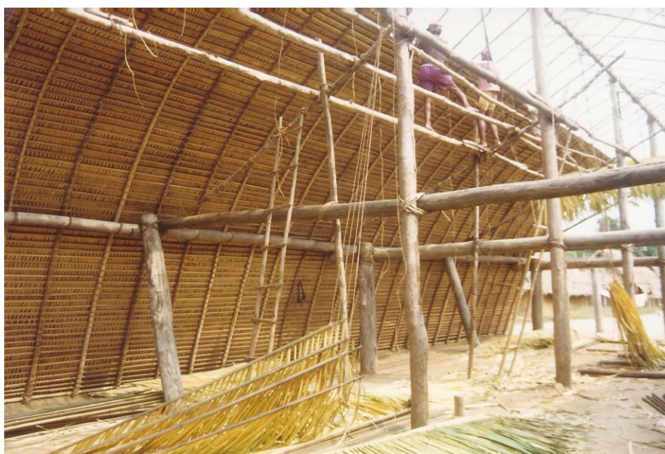
Figura 7. colocação da cobertura de palha na tavyva .
