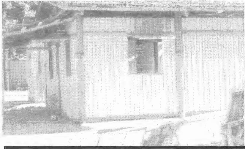
Figura 8-Habitação Popular usando peças de costaneiras na Vertical Local: Campus Experimental da LBA,Cuiabá ,Mato Grosso, 1987
