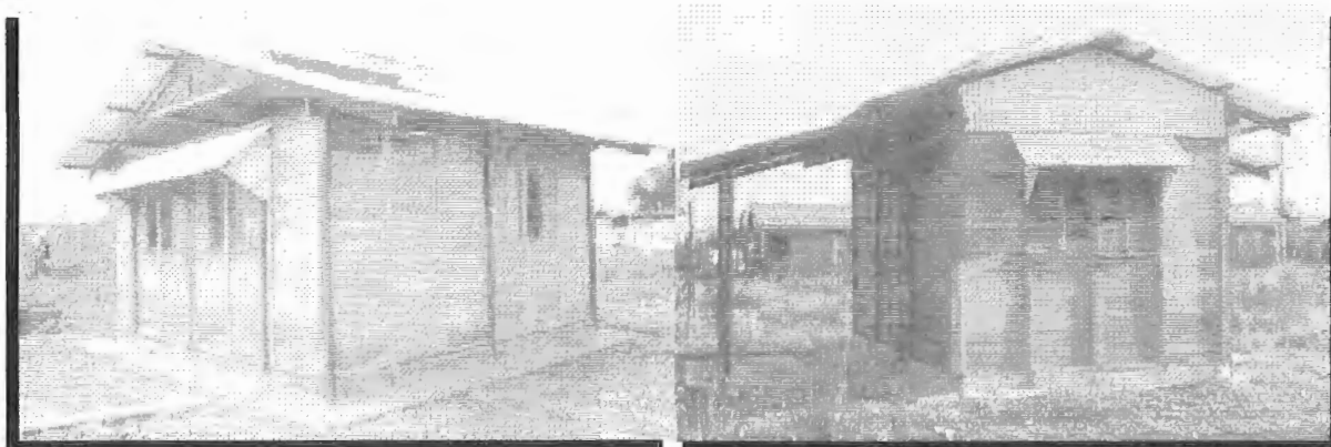
Figura 6: Habitação Popular modelo com painel ventilado “Tipo Veneziana”
