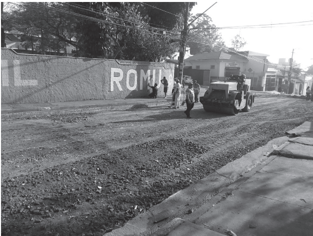
FIGURA 33.18 Execução de sub-base com agregado de RCD misto.
