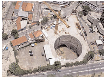
Figura 2 - Vista aérea antes do colapso
