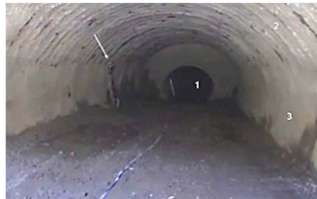
Figura 5 - Imagem capturada do vídeo encaminhado pelo Metrô ao IPT. A filmagem foi feita pela equipe de fiscalização do Metrô no dia 11/01/2007, no túnel da Estação Pinheiros, portanto, na véspera do acidente. A seta indica equipe realizando medidas de instrumentação interna no túnel (1- túnel de via sentido Faria Lima; 2- calota com as marcas das cambotas, e 3- parede do 1º rebaixo). Notar que
