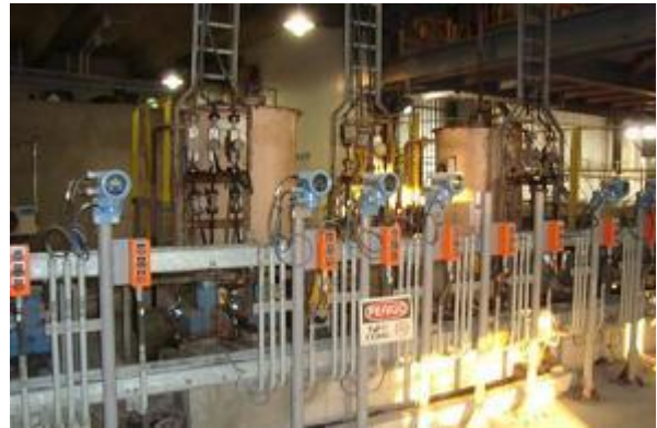
Figura 2. Sistema de dosagem de reagentes com bombas de diafragma
