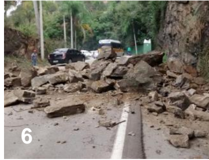
Figuras 6 e 7 – Rompimento de talude no km 117 – setembro de 2015 (Folha do Litoral Norte, 2015 b).
