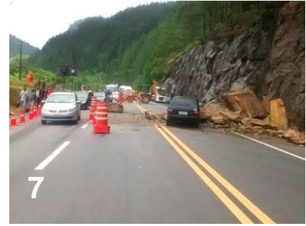
Figuras 6 e 7 – Rompimento de talude no km 117 – setembro de 2015 (Folha do Litoral Norte, 2015 b).
