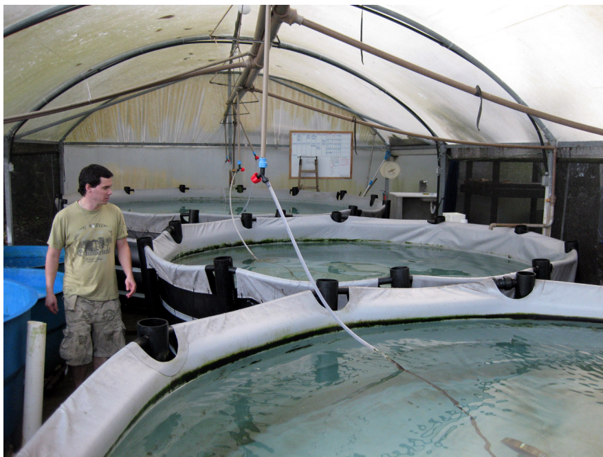
A infraestrutura montada pelo LAMEROA para a piscicultura de garoupas no CEBIMar/USP contempla tanques de até 20.000 litros de água do mar corrente com aeração. Foto: Luciano Abel.
