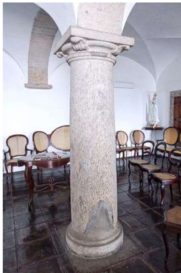
FIGURA 20.9: Pilar de gnaiss no Mosteiro de São Bento, Rio de Janeiro.
