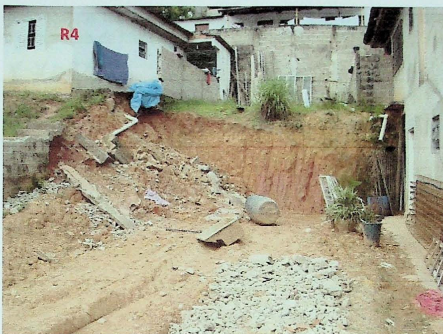
Foto 1 – Setor S1. Estrutura do solo no local. Observa-se o solo saprolítico, silto-arenoso, de cor roxa, acima do qual ocorre o solo coluvionar, argiloso, marrom, caracterizado pela presença de linhas de pedra. Ao lado esquerdo da foto, residência com risco muito alto de solapamento (R4). Intervenção: construção de muro flexural de concreto.
