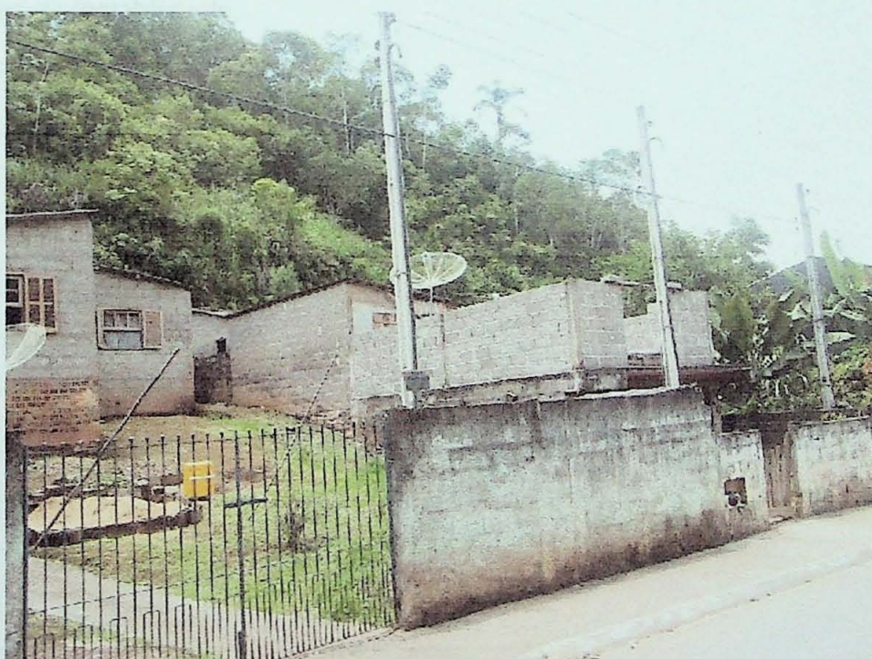
Foto 18 – Vista geral do talude de corte aos fundos das residências no setor S2. Verifica-se que o talude está totalmente coberto por vegetação nativa em estágio de regeneração. Observam-se árvores de grande porte muito próximas ao talude em situação de pouca estabilidade.
