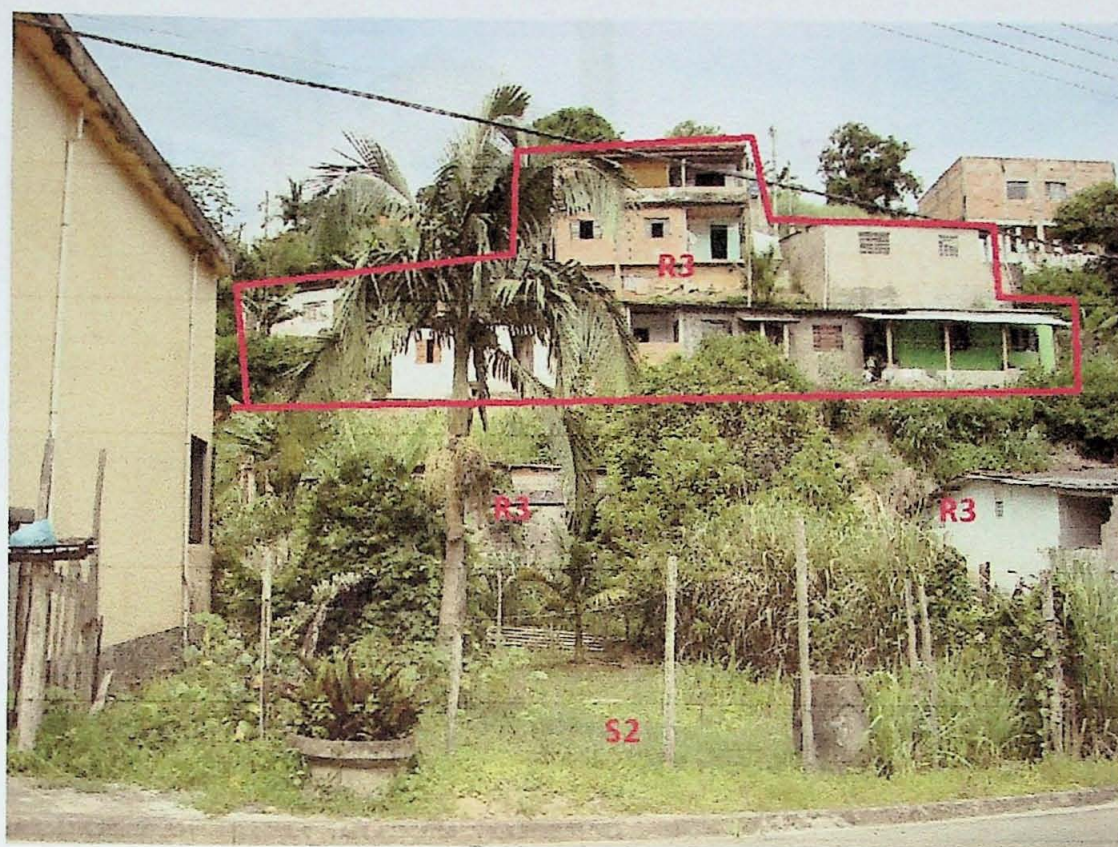
Foto 8 – Setor S2. Residências dispostas entre talude de corte. Recomenda-se proteção deste talude e drenagem das águas provenientes de montante
