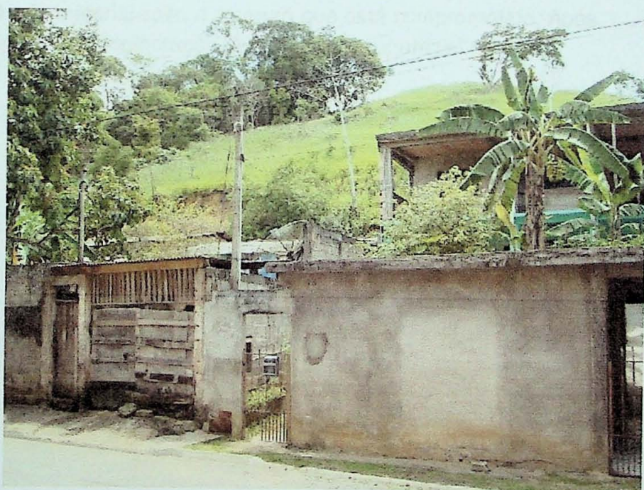
Foto 13 – Setor S1 – Cicatriz de escorregamento em talude nos fundos da residência de número 55 da Rua Quirangozi. Foi identificado um total de cinco casas neste setor com grau de risco R4.
