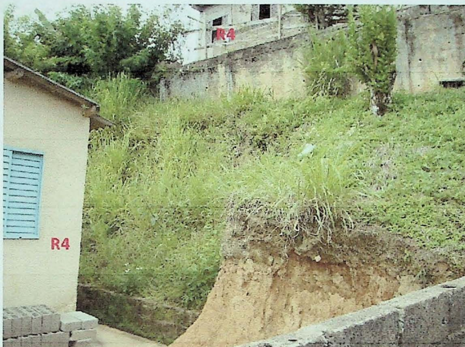
Foto 5 – Setor S1. Residência de número 252. Apresenta um talude de corte e aterro e no topo deste um muro de arrimo com sinais de instabilidade – risco muito alto.
