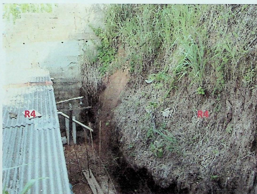
Foto 2 – Setor S1. Residência número 184. Alto risco devido à possibilidade de atingimento por deslizamento em talude de corte subvertical, com 5 metros de
