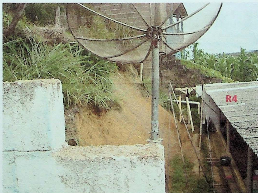
Foto 4 – Setor S1. Cicatriz de escorregamento em talude de corte. Risco a moradia de número 200 (base). Acima encontra-se a residência de número
