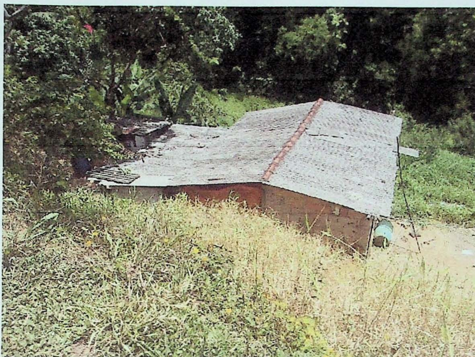
Foto 20 – Residência em risco muito alto, situada a jusante de talude de aterro com sinais de instabilidade. Neste caso é necessária a realização de obra de contenção no aterro.
