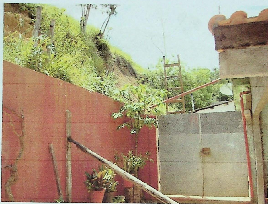
Foto 12 – Setor S1 – Talude com cicatriz de escorregamento próximo à residência e comércio. Situação de risco muito alto.
