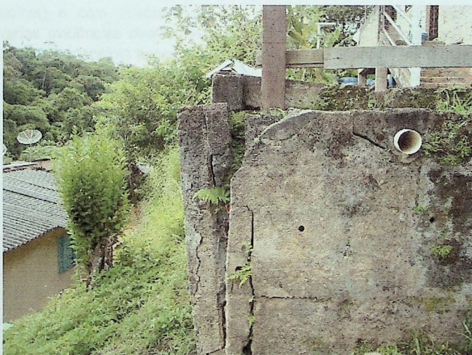
Foto 5 – Setor S1. Residência de número 252. Apresenta um talude de corte e aterro e no topo deste um muro de arrimo com sinais de instabilidade – risco muito alto.
