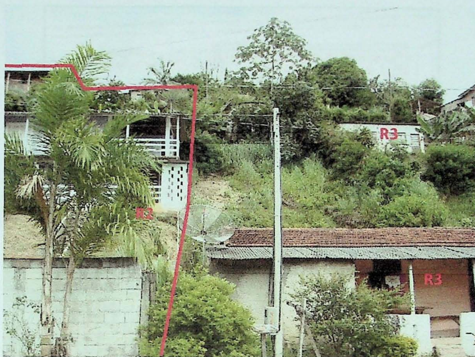
Foto 10 – Detalhe da foto anterior. Nota-se a declividade com risco de solapamento (topo) e atingimento (base).
