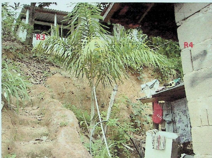
Foto 3 – Setor S1. Residência número 175 em risco de atingimento R4 (base). A residência acima do talude pode sofrer solapamento se ocorrer evolução do processo erosivo. Interferência: proteção do talude com concreto projetado.
