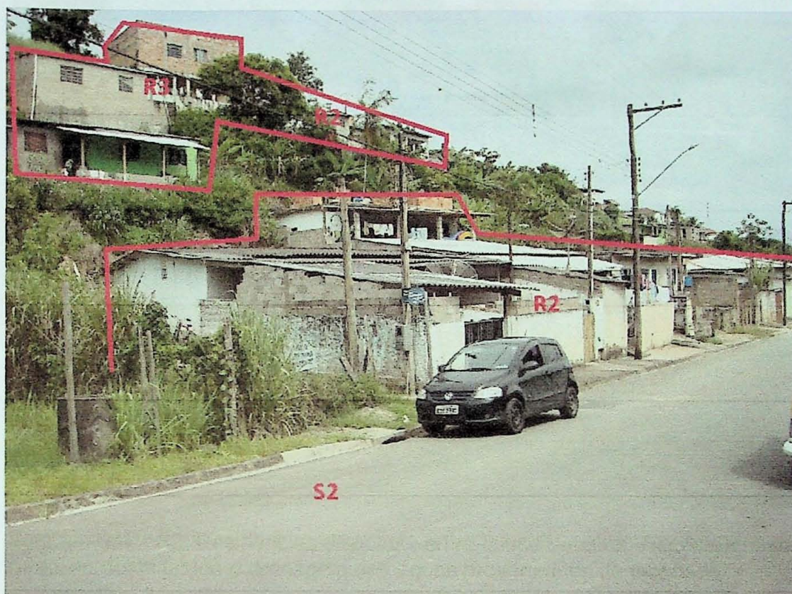
Foto 7 – Setor S2 - talude com vegetação em sua maior parte inadequada (bananeiras) e com ausência de um sistema de drenagem. Não foram observadas evidências diretas de movimentação, porém há necessidade de remoção das bananeiras acompanhada de plantio de espécies adequadas para talude, como bambus, vetiver e árvores de pequeno porte. Aconselha-se ainda implantar sistema de drenagem e captação nos fundos das residências superiores, beneficiando as quinze residências localizadas na base, e congelamento do processo de ocupação neste setor.
