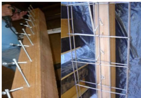
Figura 5 – Confeção de vigas mistas com conectores tipo “X”
